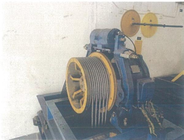
3. 对曳引机及制动器进行曳引能力和制动力测试，并对制动器复位弹簧标尺位置进行确认。
